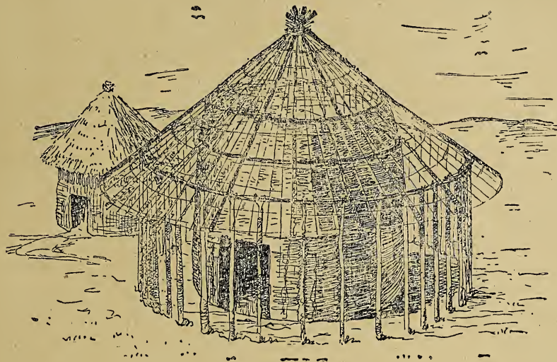
Hütte im Rohbau.
